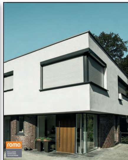
Rollladensystem in der Fassade integriert
